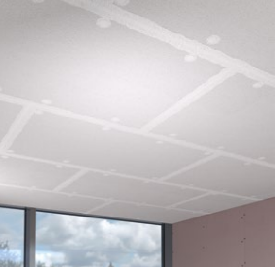
1B. A seguire si effettua la stuccatura con INN Stucco da noi fornito, che ha la stessa composizione della mousse del pannello, così da garantire il mantenimento dell'assorbimento acustico su tutta la superficie. È garantita inoltre l'elasticità necessaria che evita il ricorso a giunti elastici.
