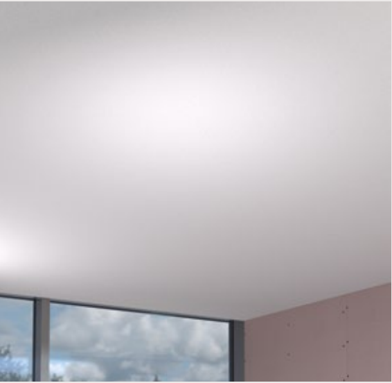
3. Infine, con l'asciugatura perfetta della prima rasatura, si potrà procedere con la rasatura finale sempre con INN Fin . La finitura viene fornita colorata in pasta.
