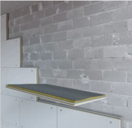
1. Stesura colla cementizia INN Colfiss e fissaggio pannelli con tasselli e rondelle.
