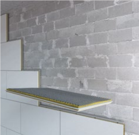
1. Stesura colla cementizia INN Colfiss e fissaggio pannelli con tasselli e tasselli idonei.
