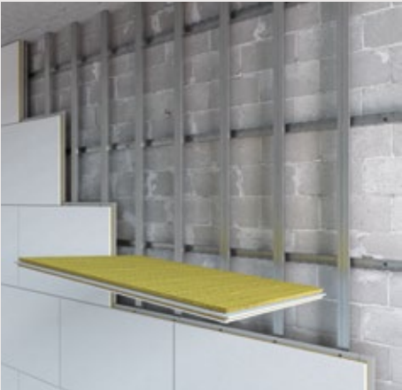
1. Fissaggio pannelli sulla struttura con viti su dentello.
