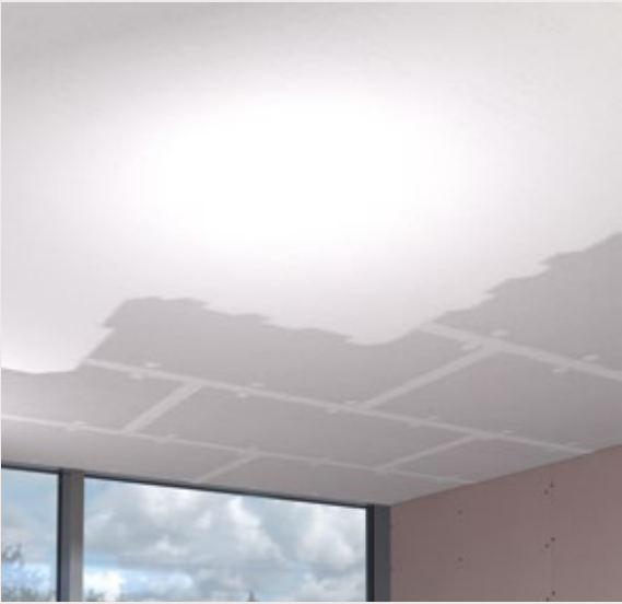
2. Quando la stuccatura sarà perfettamente asciugata, si potrà procedere con una prima rasatura utilizzando il nostro rasante appositamente formulato, INN Fin .
