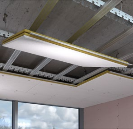
1A. Si procede, quindi, con l'applicazione dei pannelli alla struttura metallica fissandoli con viti autofilettanti e rondelle. Un dentello perimetrale (sistema maschio-femmina) facilita il sostegno del pannello successivo durante le operazioni di fissaggio dei pannelli con le viti.
