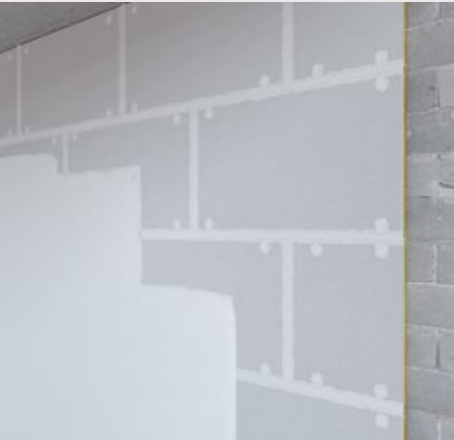
2. Stuccatura fughe e fori viti con INN Stucco a completa asciugatura eseguire una prima mano di rasante INN Fin .
