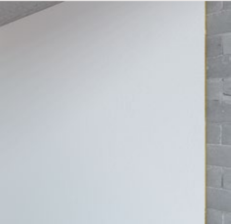
3. A completa asciugatura eseguire seconda mano di rasante INN Fin .
